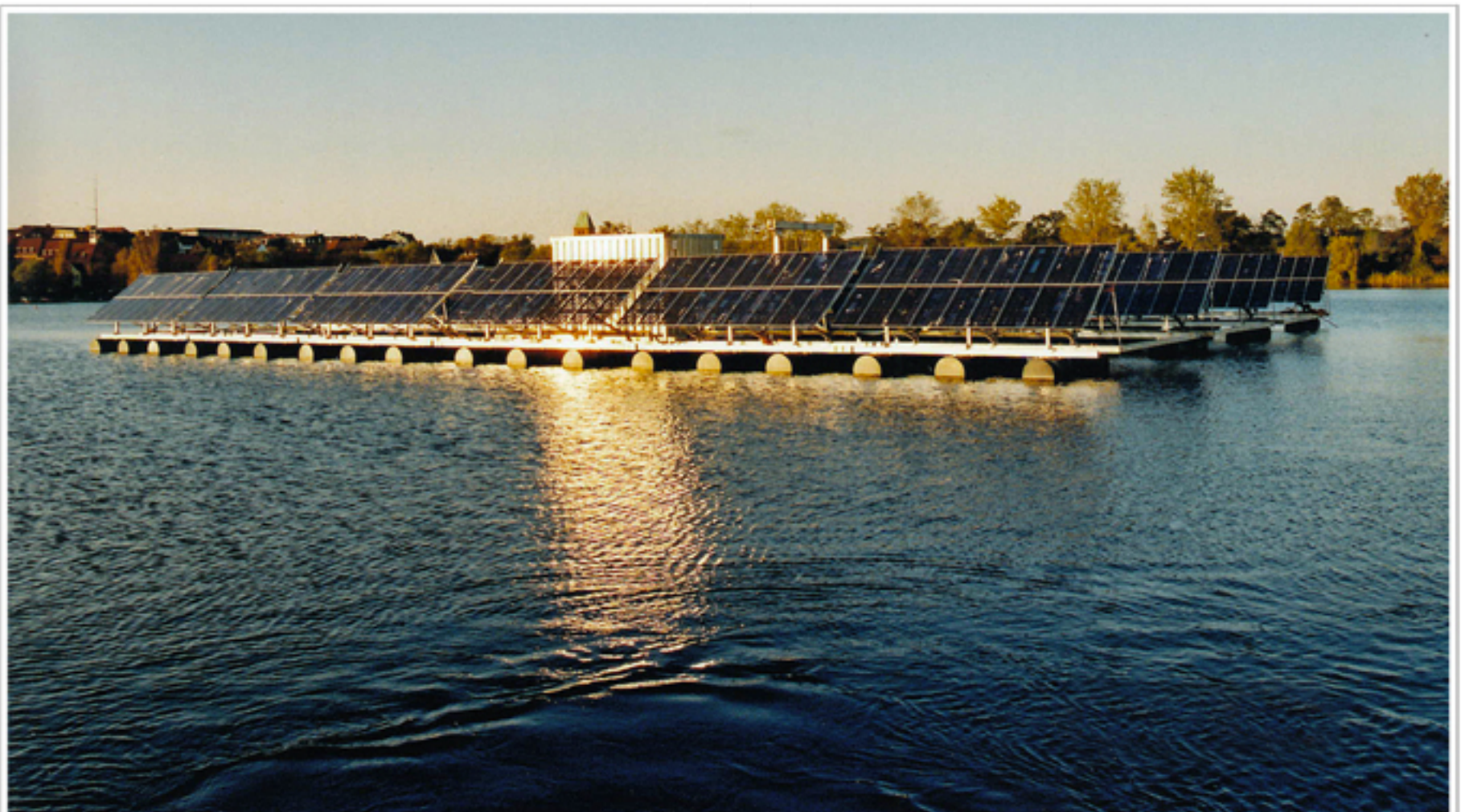
Tiefenwasserbelüftung, Kleiner Kuchensee, Ratzeburg
