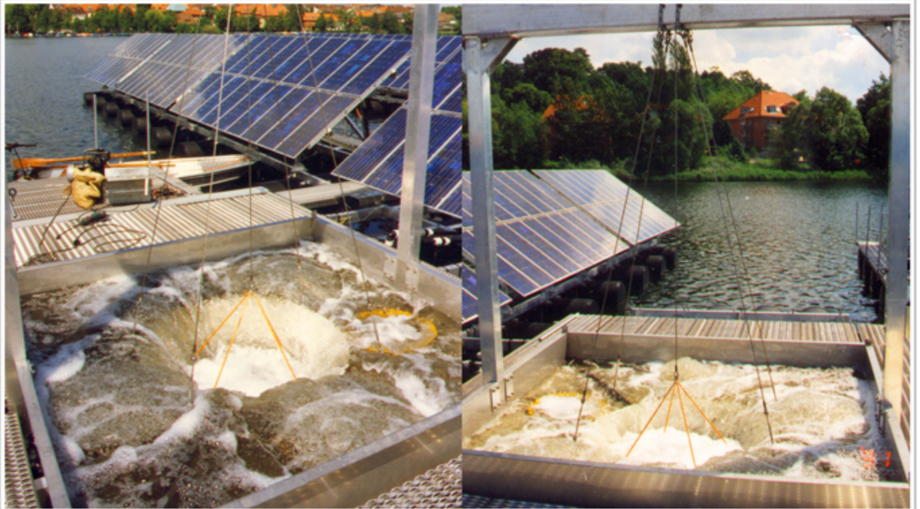
Tiefenwasserbelüftung, Kleiner Kuchensee, Ratzeburg
